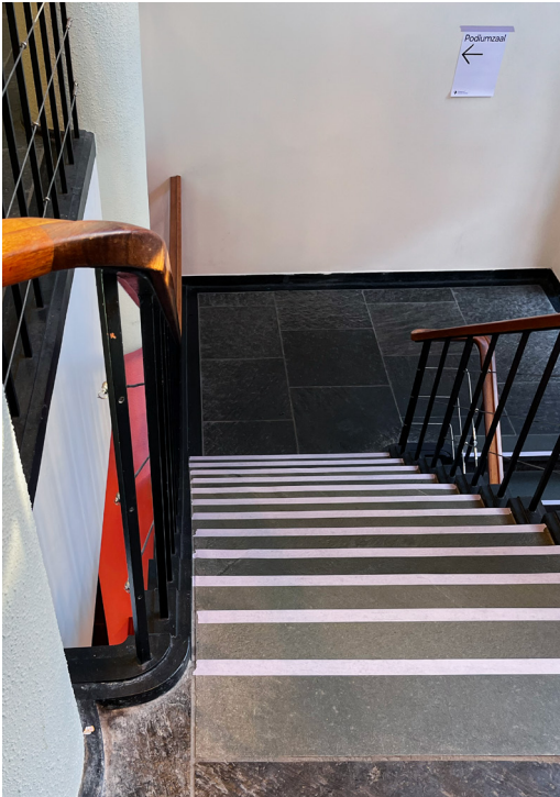
Tijdelijke interventies, zoals bestickering van traptreden, helpen om een toegankelijker evenement mogelijk te maken.
